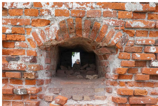
Gambar 35 Jendela kecil yang lubang bagian dalamnya lebih lebar dari lubang bagian luar kecil Sumber: Tim Dokumentasi, 2022
