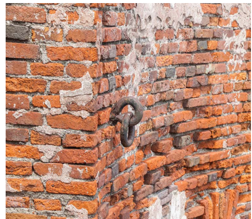
Gambar 39 Cincin besi yang diduga digunakan sebagai ring pengait salah satu bagian atap
