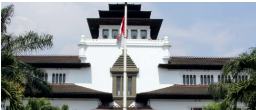
Gambar 11 Bangunan Cagar Budaya Gedung Sate, Kota Bandung, Jawa Barat
