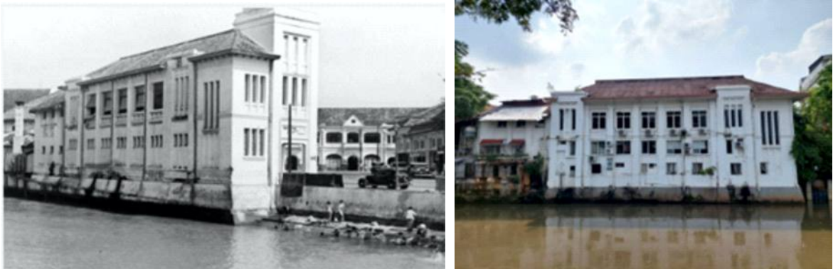
Foto 9. Gedung Eks Toko Tio Tek Hong sisi selatan (dilihat dari kanal); terlihat bagian-bagian yang diduga masih asli pada tampak sisi selatan Sumber: Survei PKCB, 2021
