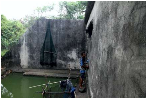
Foto 21. Dinding perkuatan di sebelah pintu masuk (Survei TACB 2017)
