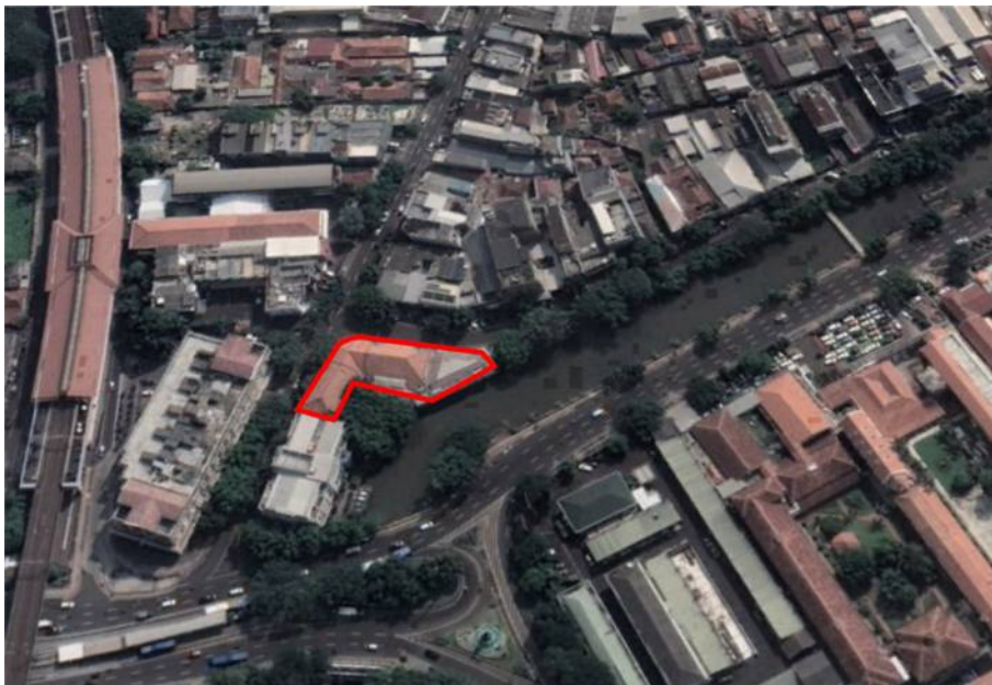
Foto 1. Foto Udara Lokasi Eks Toko Tio Tek Hong Sumber: Google Earth, 2021
