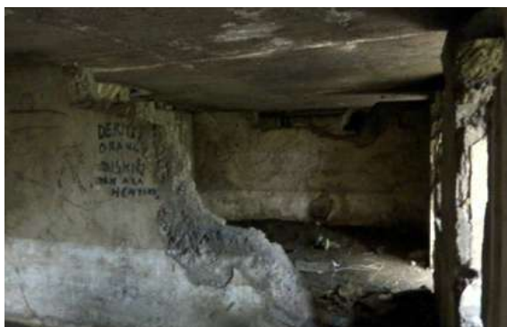
Foto 14. Bagian dalam Bangunan G4 (Survei TACB 2017)
