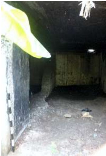
Foto 7. Pintu masuk Bangunan G2 (Survei TACB 2017)
