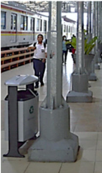
Foto 34. Tiang peron asli berbentuk segi delapan 2016 (Dok. Danang Triratmoko 2016)
