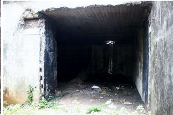
Foto 11. Pintu masuk Bangunan G3 (Survei TACB 2017)
