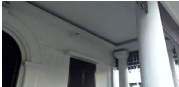
Foto 9. Plafon pada teras bangunan utama (Survei TACB 2019)
