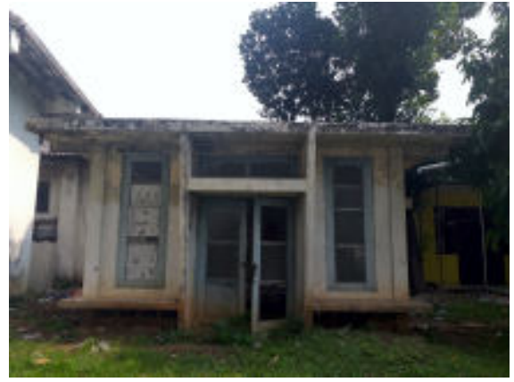
Foto 14. Bekas bangunan menara air (Survei TACB, 2020)
