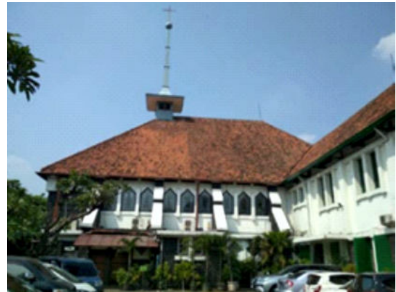
Foto 4. Tampak utara (Survei TACB, 2018)
