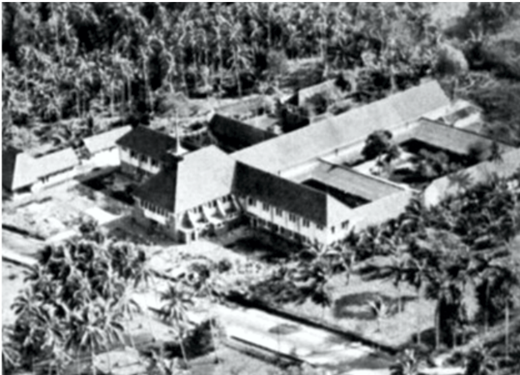
Foto 2. Kompleks Bangunan Vincentius Putri ( https://smpsantovincentius.weebly.com )
