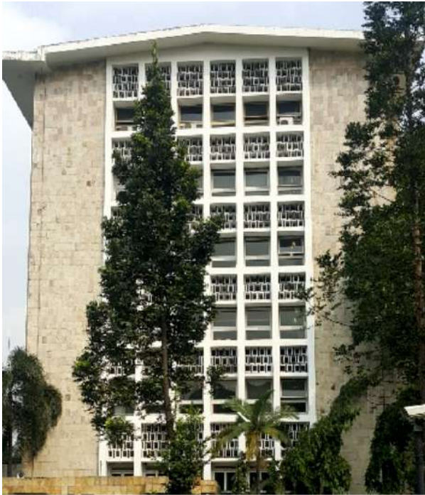
Foto 3. Penggunaan Kisi-kisi dan Krawangan (Survey PDA, 2018)
