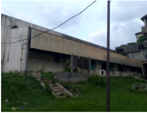
Foto 13. Bangunan lab yang sudah lama tidak terpakai (Bangunan No 8) (Survei TACB, 2020)
