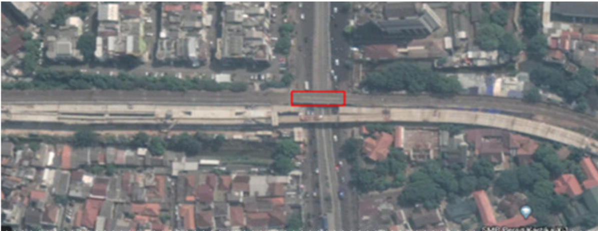
Foto 1. Foto Udara Jembatan Kereta Jalan Matraman Raya (google.earth.co.id)
