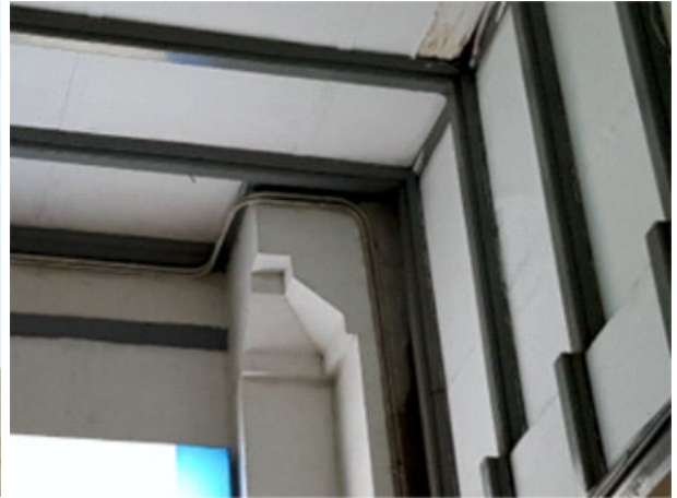
Foto 22. Kepala kolom pada interior lobby Stasiun Jatinegara (Survei TACB 2019)
