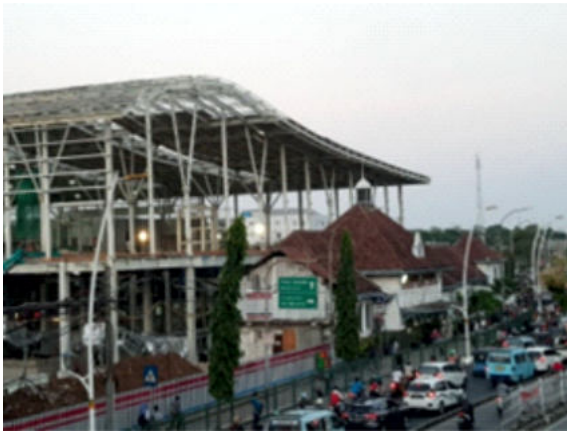
Foto 26. Renovasi Stasiun Jatinegara sisi barat daya (Survei TACB 2019)
