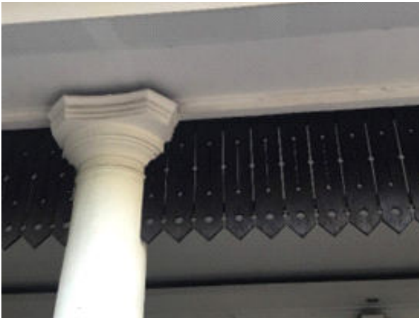
Foto 10. Ornamen renda dari kayu pada bawah atap teras bangunan utama (Survei TACB 2019)
