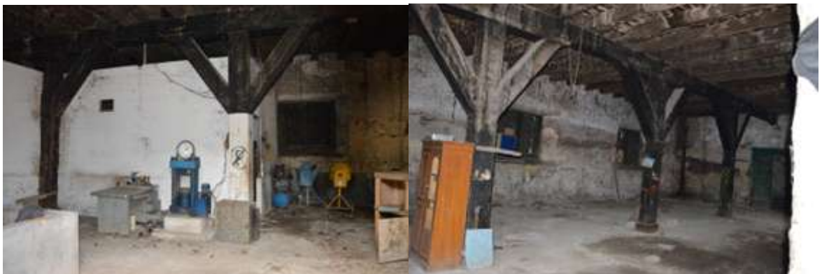
Foto 8. Ruang dalam Gudang Timur
