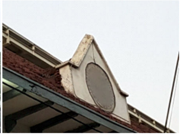
Foto 10. Jendela atap (dormer) pada Stasiun Jatinegara (Survei TACB 2019)
