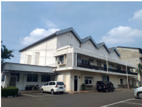
Foto 6. Bangunan 2 yang terdapat di seberang bangunan utama (Survei TACB, 2020)
