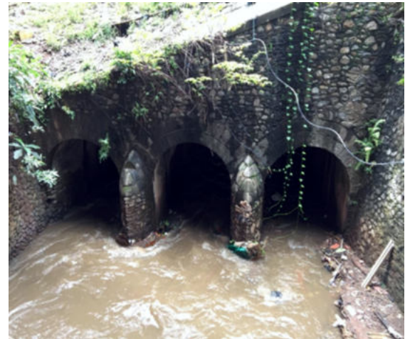
Foto 19. Pelengkung pada Jembatan Terowongan Tiga. (Survei TACB 2020)
