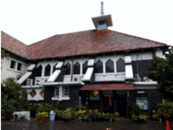
Foto 3. Tampak selatan (Sudin Parbud Jakarta Timur, 2017)
