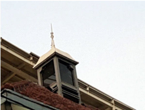
Foto 11. Menara atap ( cupola ) Stasiun Jatinegara (Survei TACB 2019)
