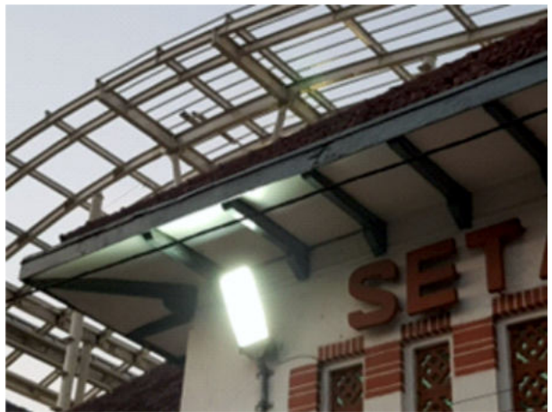
Foto 18. Tritisan atap yang lebar (Survei TACB 2019)
