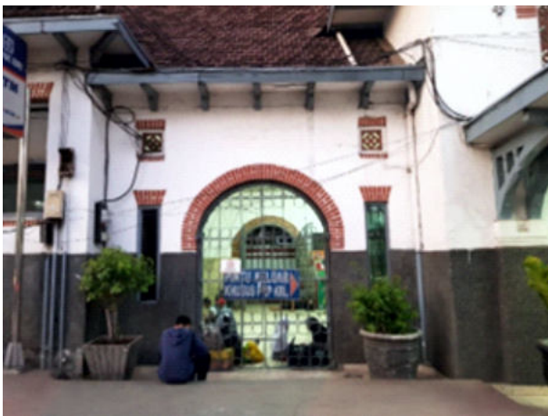
Foto 23. Dinding batu setinggi \pm 1.5 meter pada dinding luar bangunan (Survei TACB 2019)
