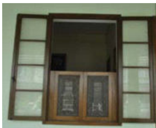
Foto 15. Jendela rangkap (Survei TACB, 2018)
