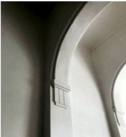
Foto 14. Pilaster dengan Pemisah Ruangan (Konglion) Tembok Sumber: Survei TACB, 2020
