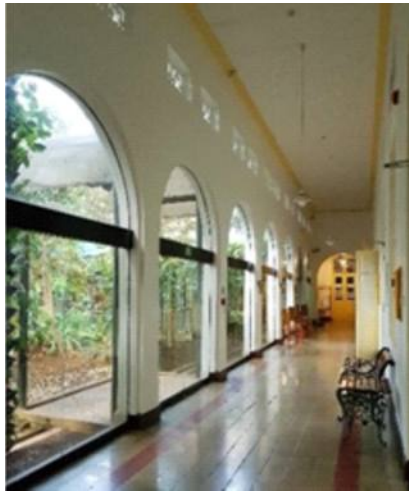
Foto 12. Selasar dengan Bukaan Lengkung Sumber: Survei TACB, 2020
