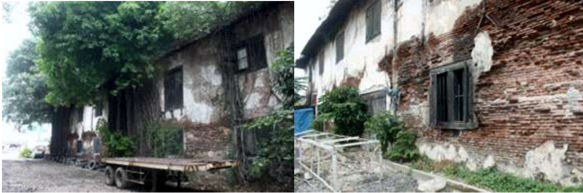
Foto 8. Dinding belakang (kiri) dan dinding depan (kanan)
