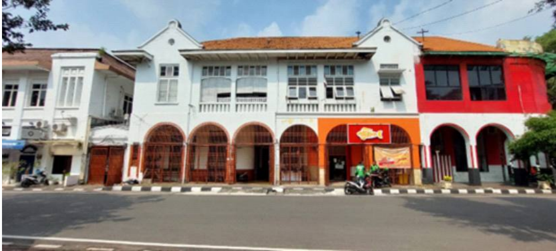
Foto 6. Bangunan yang digunakan sebagai Restoran Ngikan dan Cochoc Sumber: Survei PKCB, 2021
