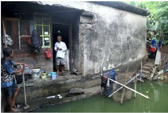
Foto 20. Bangunan G7 yang digunakan sebagai rumah penduduk (Survei TACB 2017)
