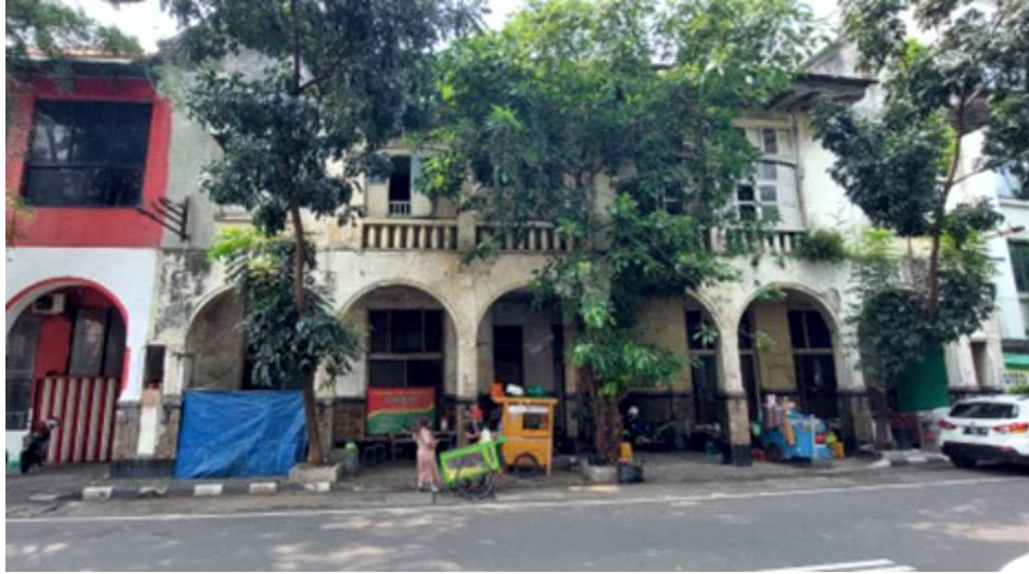
Foto 8. Bangunan Kosong Sisi Selatan Sumber: Survei PKCB, 2021
