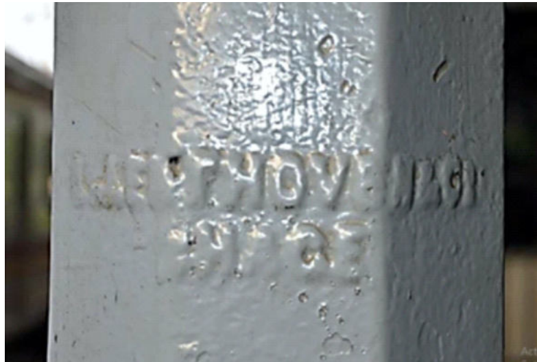
Foto 36. Nama pabrik pembuat tiang besi peron (Dok. Danang Triratmoko 2016)
