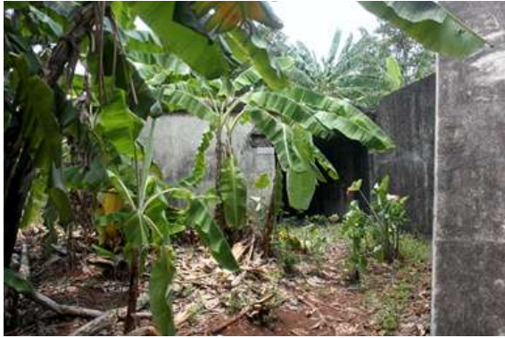
Foto 10. Kondisi sekitar Bangunan G3 (Survei TACB 2017)
