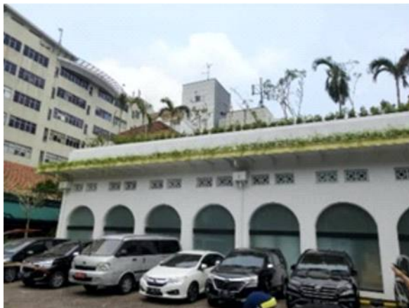
Foto 19. Bangunan Freezer Sumber: Survei TACB, 2020)
