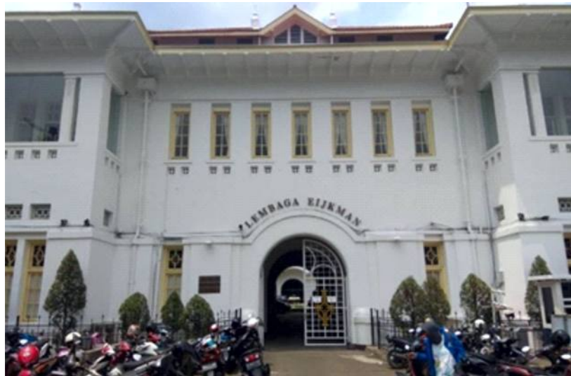
Foto 3. Pintu Masuk Gedung LBM Eijkman Sumber: Survei TACB, 2020
