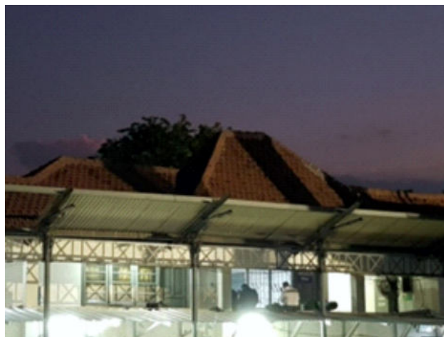
Foto 30. Tiang struktur peron asli Stasiun Jatinegara yang dipertahankan (Survei TACB 2019)
