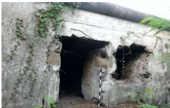
Foto 17. Bagian depan Bangunan G6 (Survei TACB 2017)
