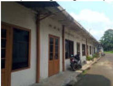
Foto 10. Bangunan yang terdapat di sisi timur bangunan utama PFN (Survei TACB, 2020)
