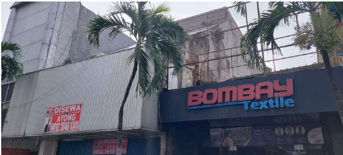
Foto 7. Tampak Samping Lantai Dua Toko Kezia Bella Internasional Sumber: Survei PKCB, 2021
