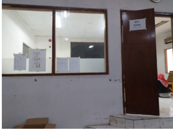
Foto 9. Ruang Istirahat pada Bangunan 2 (Survei TACB, 2020)
