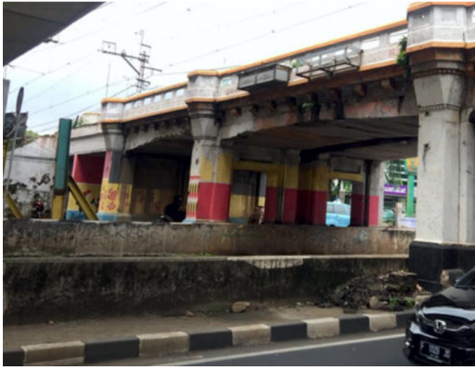
Foto 4. Lubang jembatan kereta api jatinegara (Survei TACB 2020)
