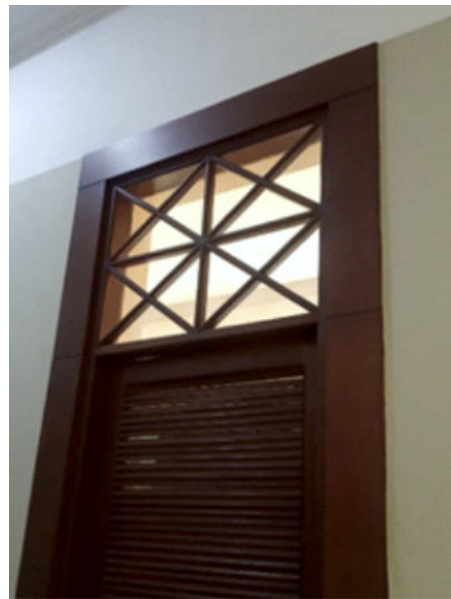
Foto 16. Pintu dengan lubang angin pada interior dalam bangunan (Dok. Alien Design Consultant)
