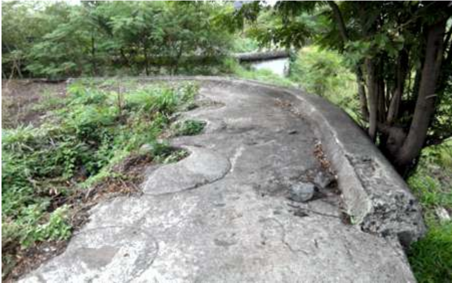
Foto 19. Bagian atap bangunan G6 (Survei TACB 2017)
