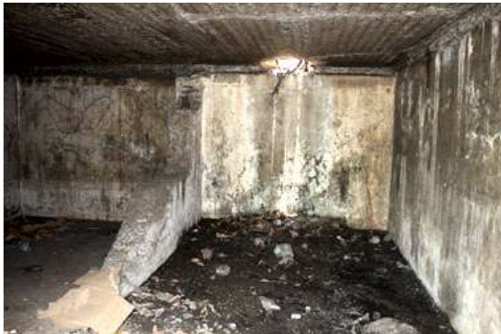
Foto 12. Bagian dalam Bangunan G3 (Survei TACB 2017)
