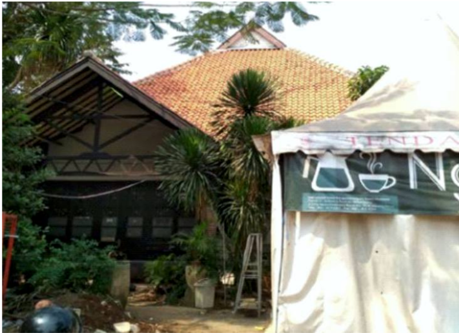
Foto 18. Tampak muka Bangunan Baru (Survei TACB, 2018)
