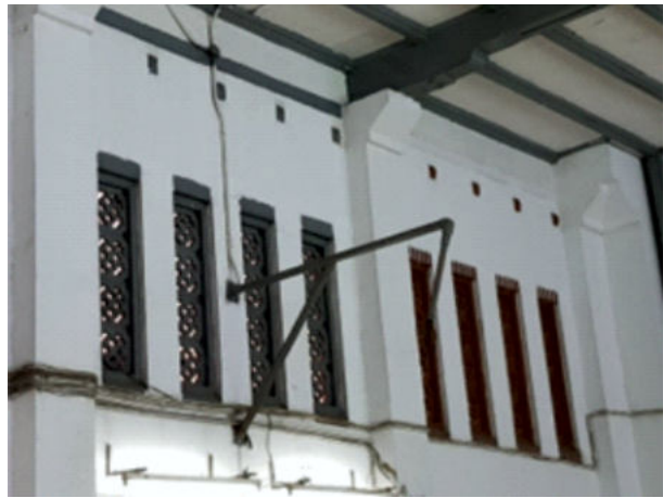
Foto 16. Deretan lubang angin Stasiun Jatinegara (Survei TACB 2019)
