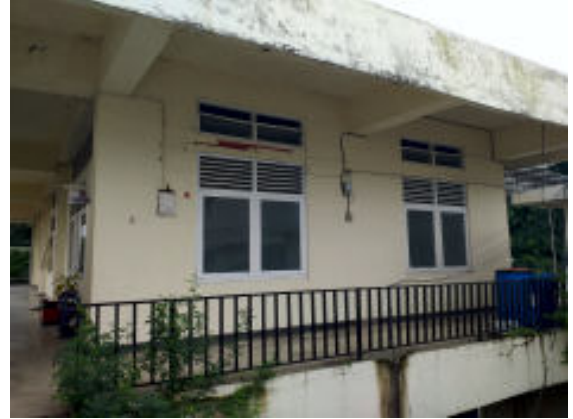
Foto 5. Tampak depan ruangan di lantai dua (Survei TACB, 2020)
