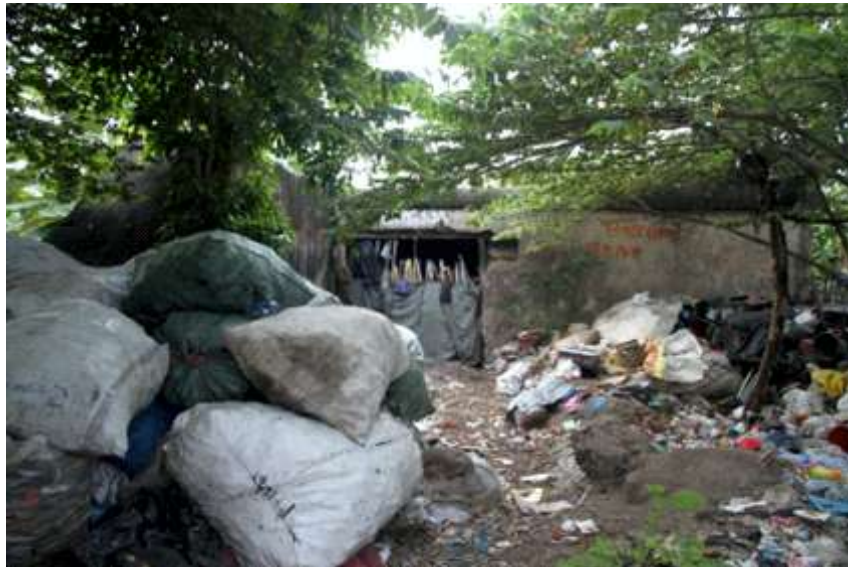
Foto 22. Kondisi bangunan G8 (Survei TACB 2017)
