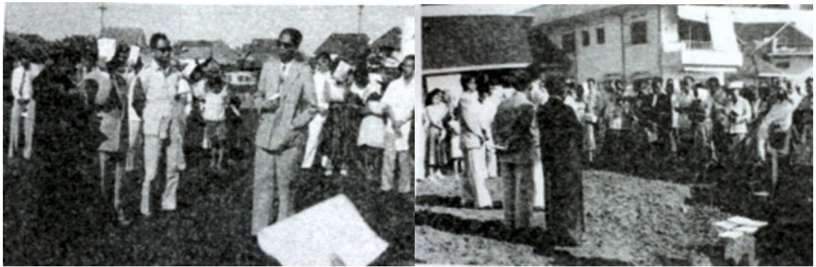
Foto 10. Peletakan batu pertama pembangunan gereja
