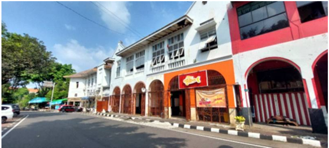
Foto 3. Koridor Bangunan Eks Toko Tio Tek Hong Sumber: Survei PKCB, 2021
