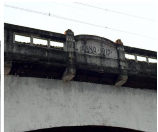
Foto 5. Angka tahun pembangunan jembatan (Survei TACB 2020)
