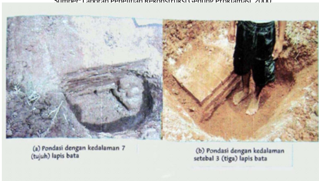
(b) Pondasi dengan Kedalaman Tiga Lapis Bata
