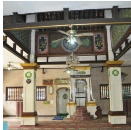
Foto 8. Tiang Sokoguru Masjid
