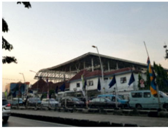
Foto 27. Renovasi Stasiun Jatinegara sisi tenggara (Survei TACB 2019)
