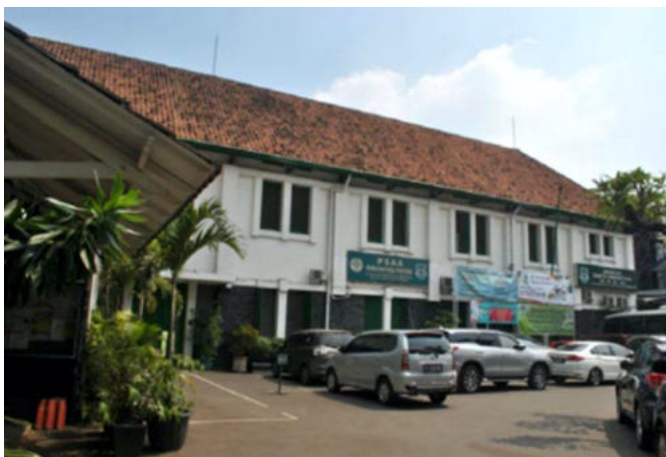
Foto 12. Tampak muka Bangunan Sisi Utara (Survei TACB, 2018)
