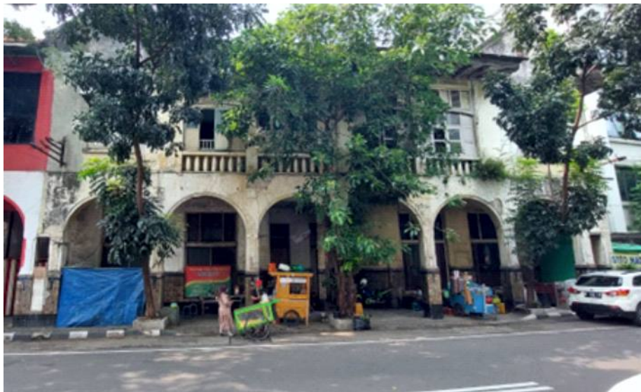
Foto 11. Kerusakan pada Bangunan Eks Toko Tio Tek Hong Sumber: Survei PKCB, 2021
