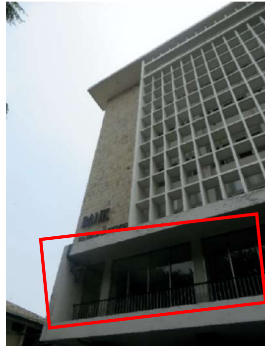
Foto 4. Lantai 2 Bangunan (Survey PDA, 2018)
