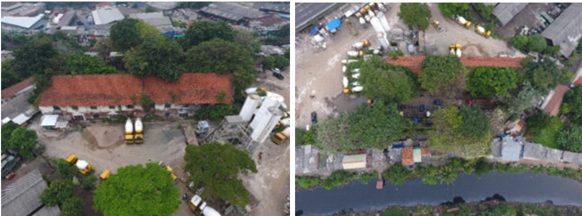
Foto 2. Bangunan dan kondisi lingkungan di sekitar Gudang Timur
