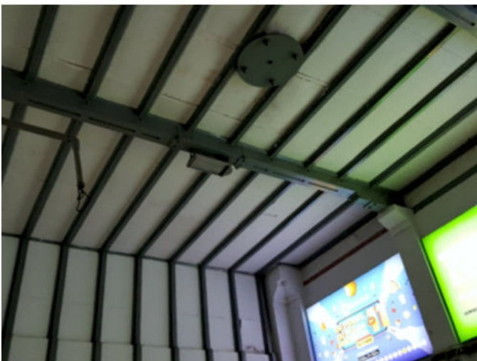
Foto 19. Rangka atap kayu pada lobby Stasiun Jatinegara (Survei TACB 2019)
