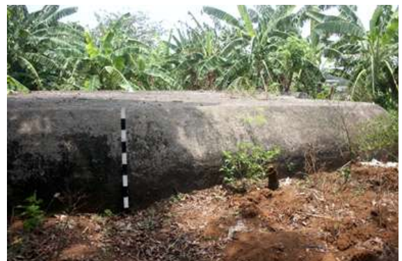
Foto 5. Sisi utara bagian atas (Survei TACB 2017)
