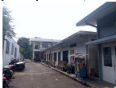
Foto 11. Terlihat dua massa bangunan yang berbeda (Survei TACB, 2020)
