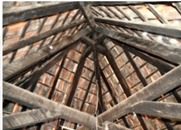
Foto 10. Konstruksi atap masjid
