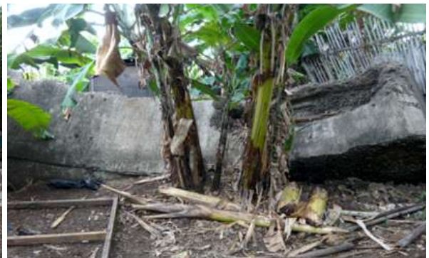
Foto 24. Tembok sisi selatan bangunan (Survei TACB 2017)
