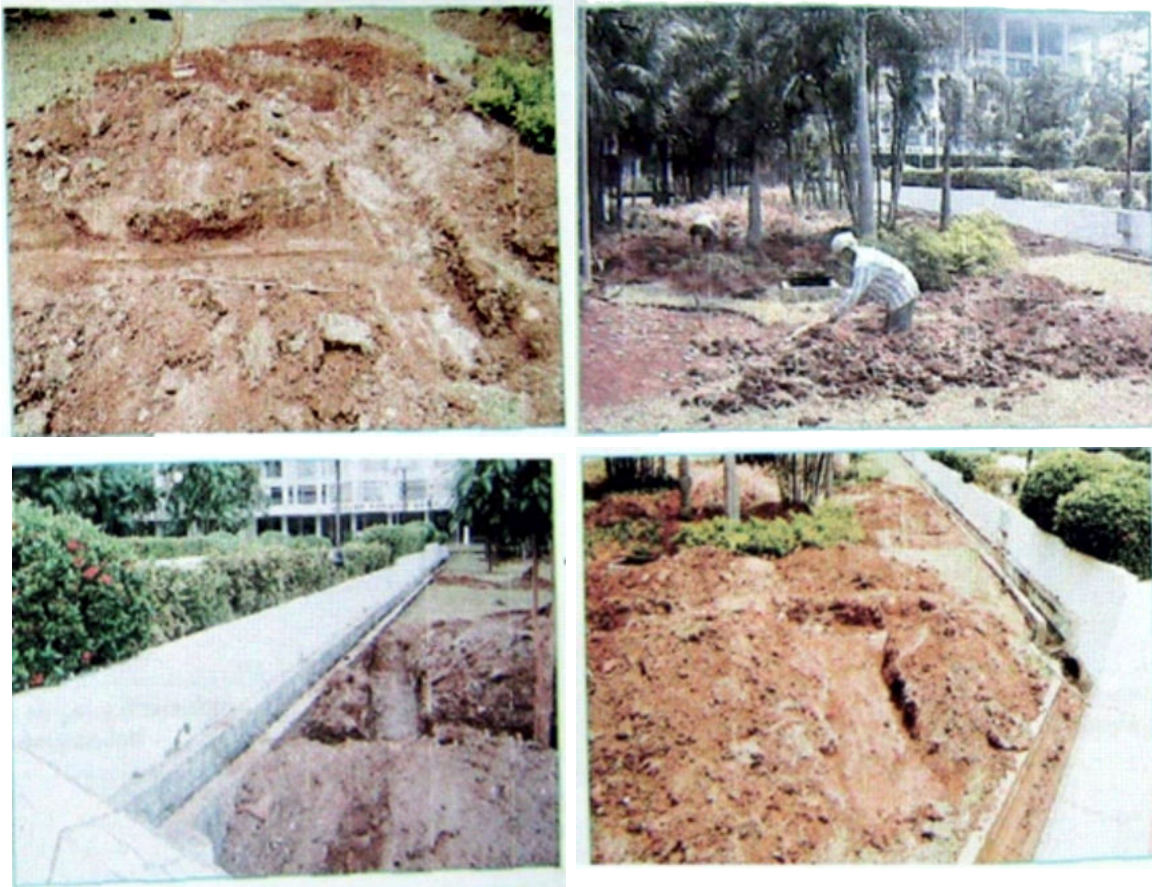
Foto 6. Penggalian Pondasi Rumah Proklamasi Sumber: Laporan Penelitian Rekonstruksi Gedung Proklamasi, 2000
