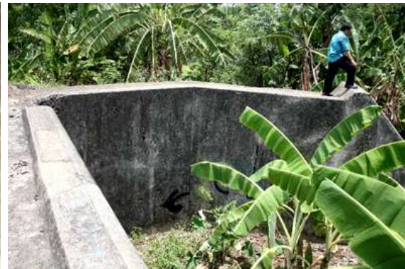
Foto 13. Dinding di depan pintu masuk Bangunan G3 (Survei TACB 2017)
