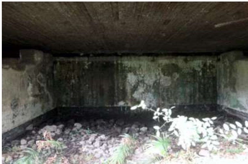
Foto 16. Bagian dalam Bangunan G5 (Survei TACB 2017)
