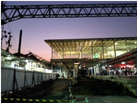
Foto 28. Renovasi Stasiun Jatinegara sisi timur (Survei TACB 2019)
