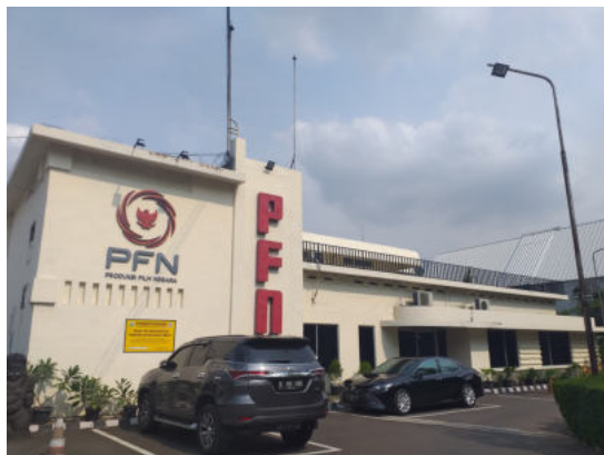
Foto 2. Terdapat Logo PFN pada tampak depan bangunan utama (Survei TACB, 2020)
