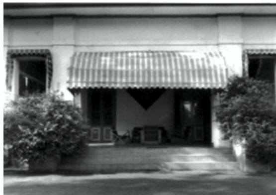
Foto 9. Teras Depan Rumah Proklamasi, Tempat Teks Proklamasi Dibacakan Oleh Bung Karno Sumber : Koleksi Indro Kusumo Wardono
