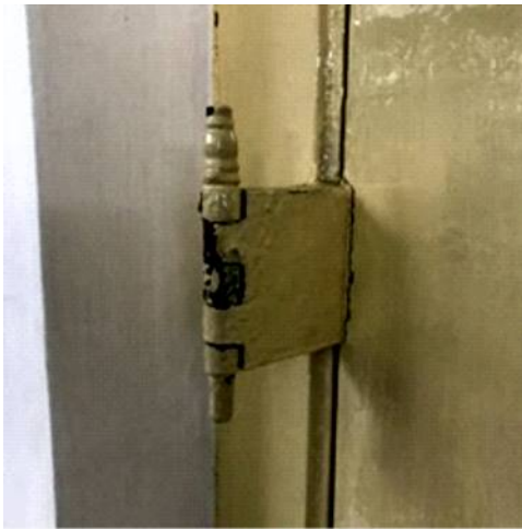
Foto 17. Engsel pintu yang menonjol (Survei TACB, 2020)
