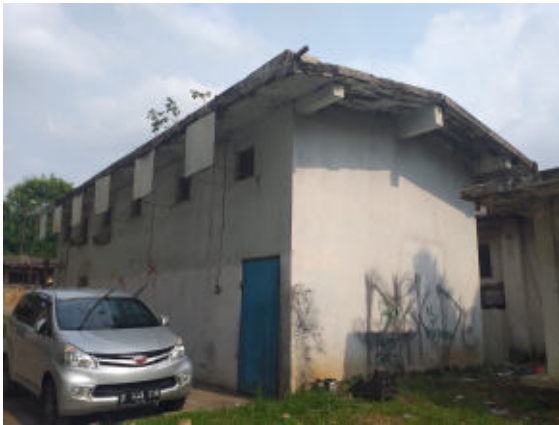
Foto 15. Bangunan No 6 (Survei TACB, 2020)
