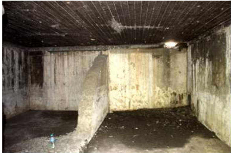
Foto 8. Bagian dalam bangunan G2 (Survei TACB 2017)
