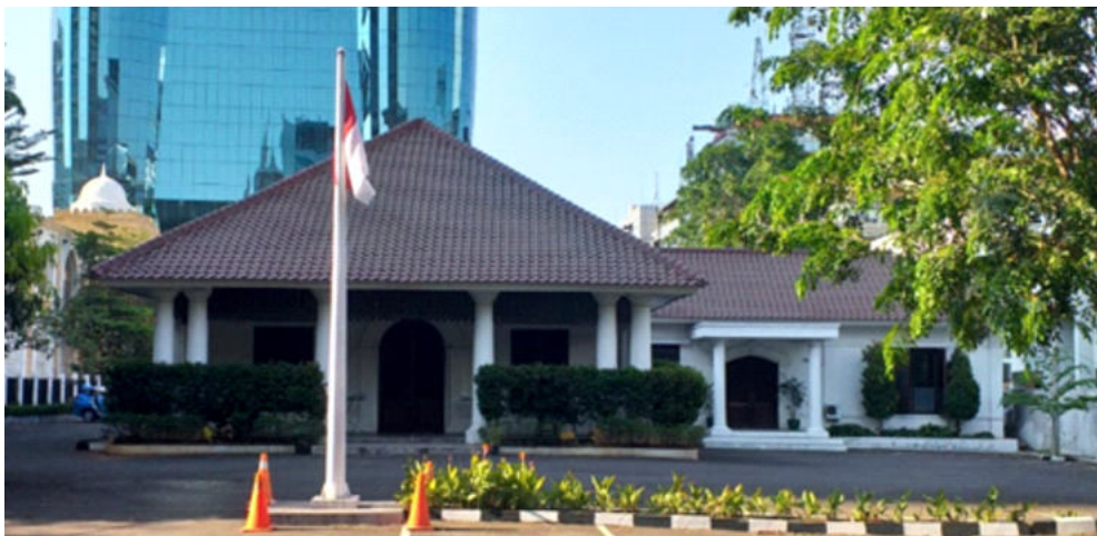
Foto 2. Tampak depan bangunan Kantor Pusat PT. Garuda Indonesia (Persero) Kebon Sirih (Survei TACB 2019)
