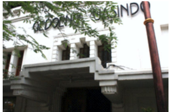
Foto 4. Profil kanopi, cantilever dan embrasure pada dinding pintu masuk
