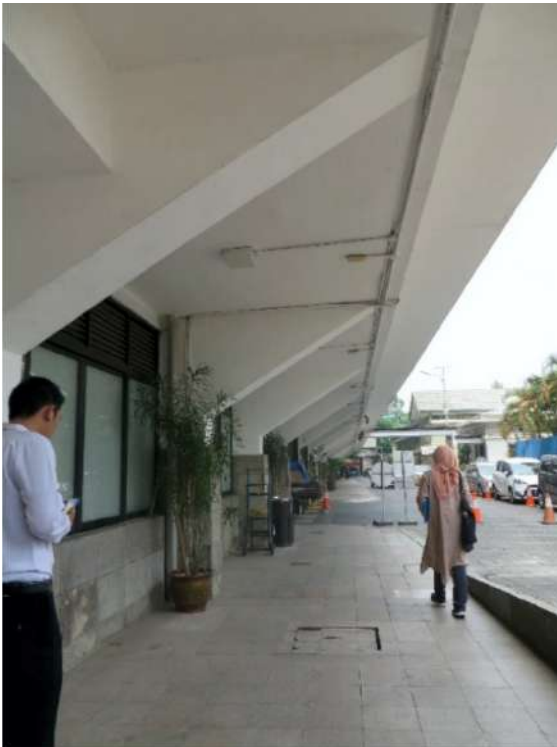
Foto 5. Teritisan dan Pilaster Penyangga (Suvey PDA, 2018)
