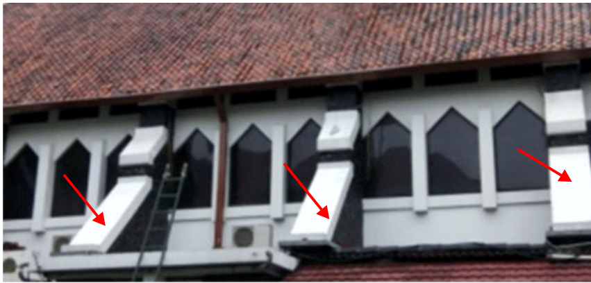
Foto 5. Dinding sisi selatan dengan Flying buttress dan jendela segi lima (Sudin Parbud Jakarta Timur, 2017)
