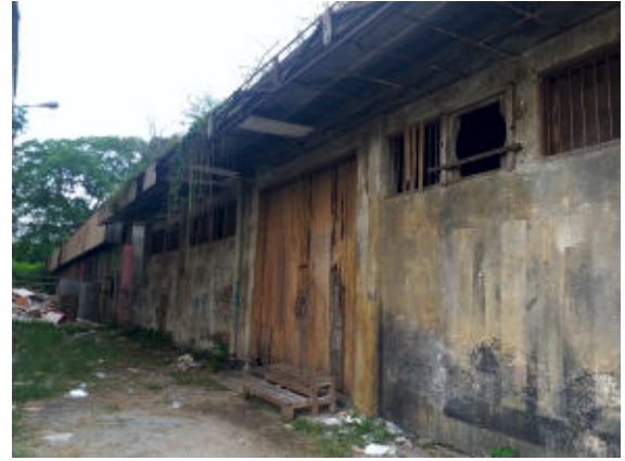
Foto 16. Bangunan No 7 (Survei TACB, 2020)
