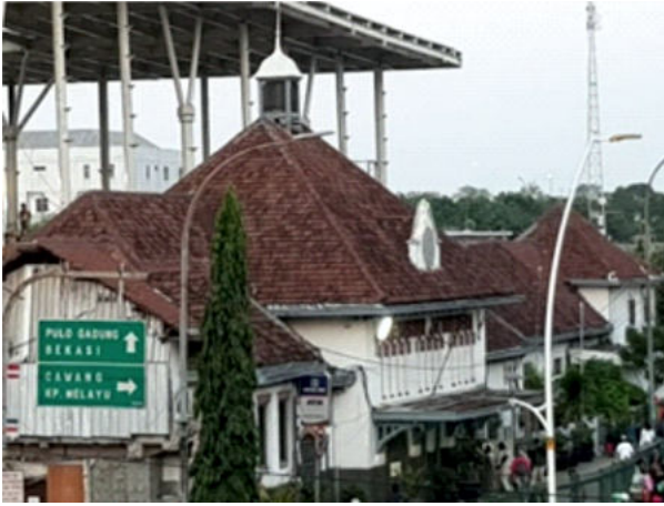
Foto 9. Atap Stasiun Jatinegara yang besar dan dengan kemiringan yang curam (Survei TACB 2019)
