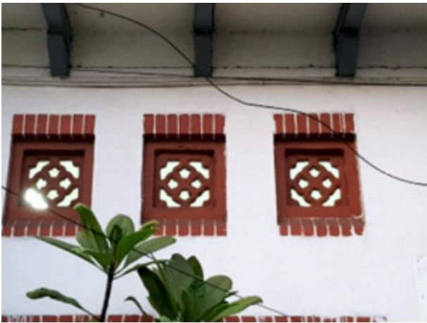
Foto 15. Detail bata rooster sebagai lubang angin (Survei TACB 2019)
