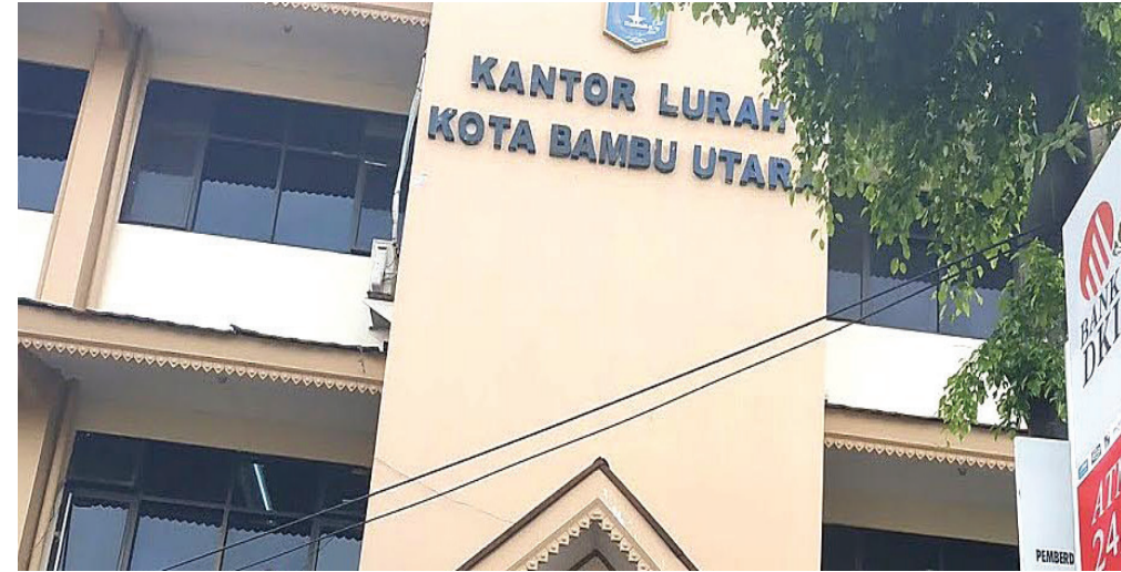
Gedung kantor Kelurahan Kota Bambu Utara yang terletak di Jl Kota Bambu Utara II.
