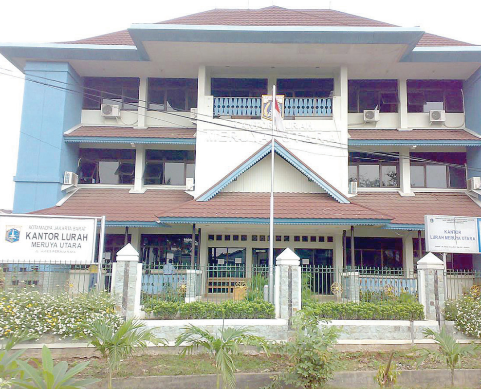
Gedung kantor Kelurahan Meruya Utara yang terletak di Jl Aries Permai No 2.
