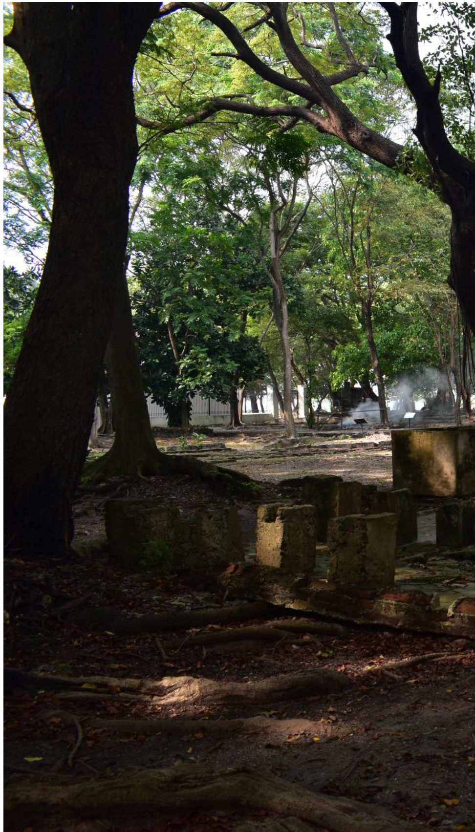
Sisa reruntuhan bangunan karantina di pulau onrust sumber : Koleksi foto Museum Kebaharian
