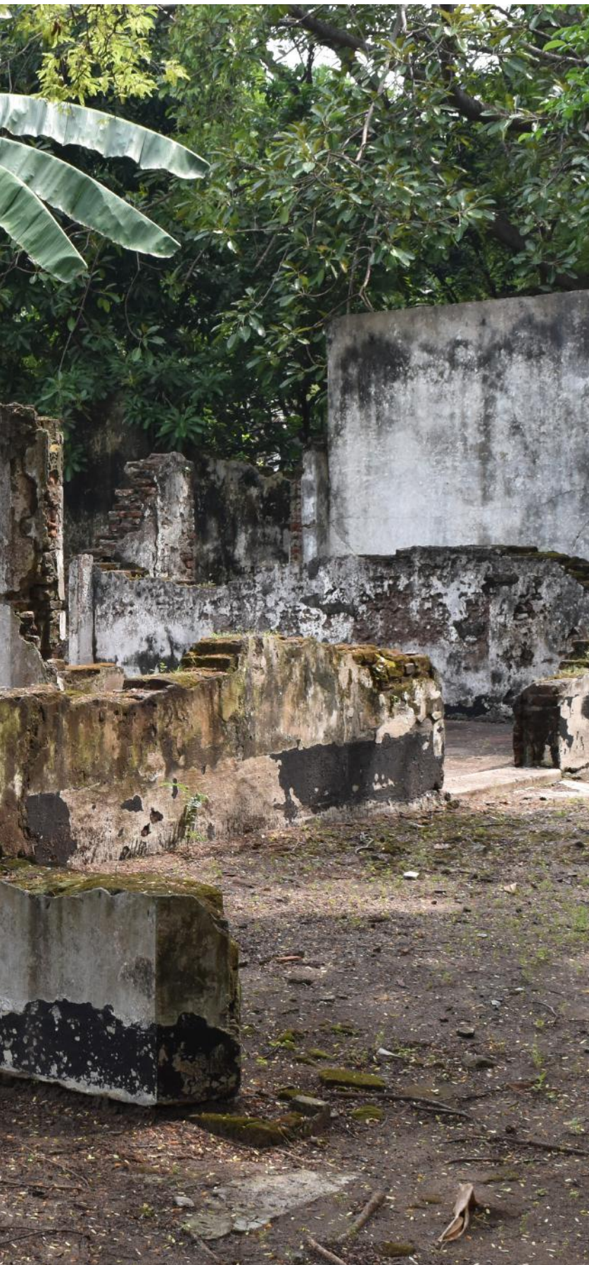
Sisa reruntuhan bangunan karantina di pulau onrust sumber : Koleksi foto Museum Kebaharian
