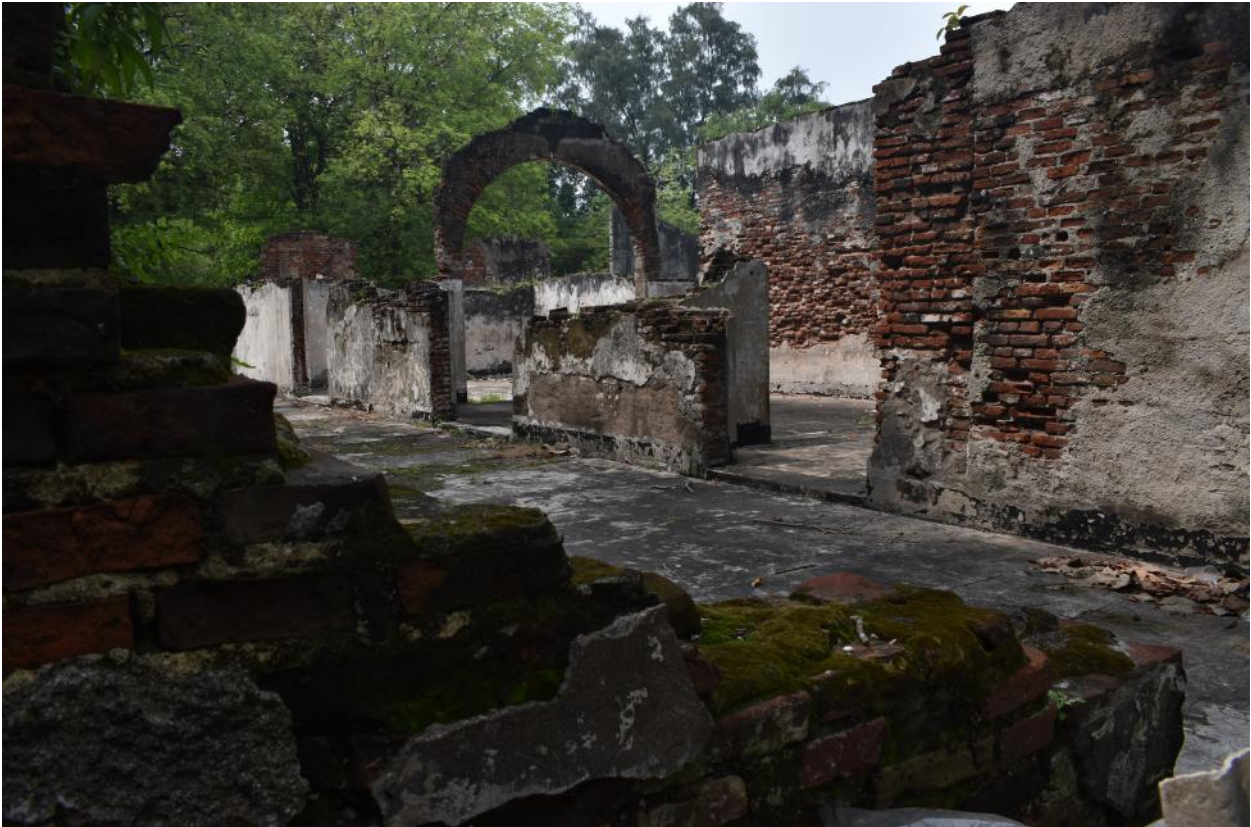
Sisa reruntuhan bangunan karantina di pulau onrust sumber : Koleksi foto Museum Kebaharian
