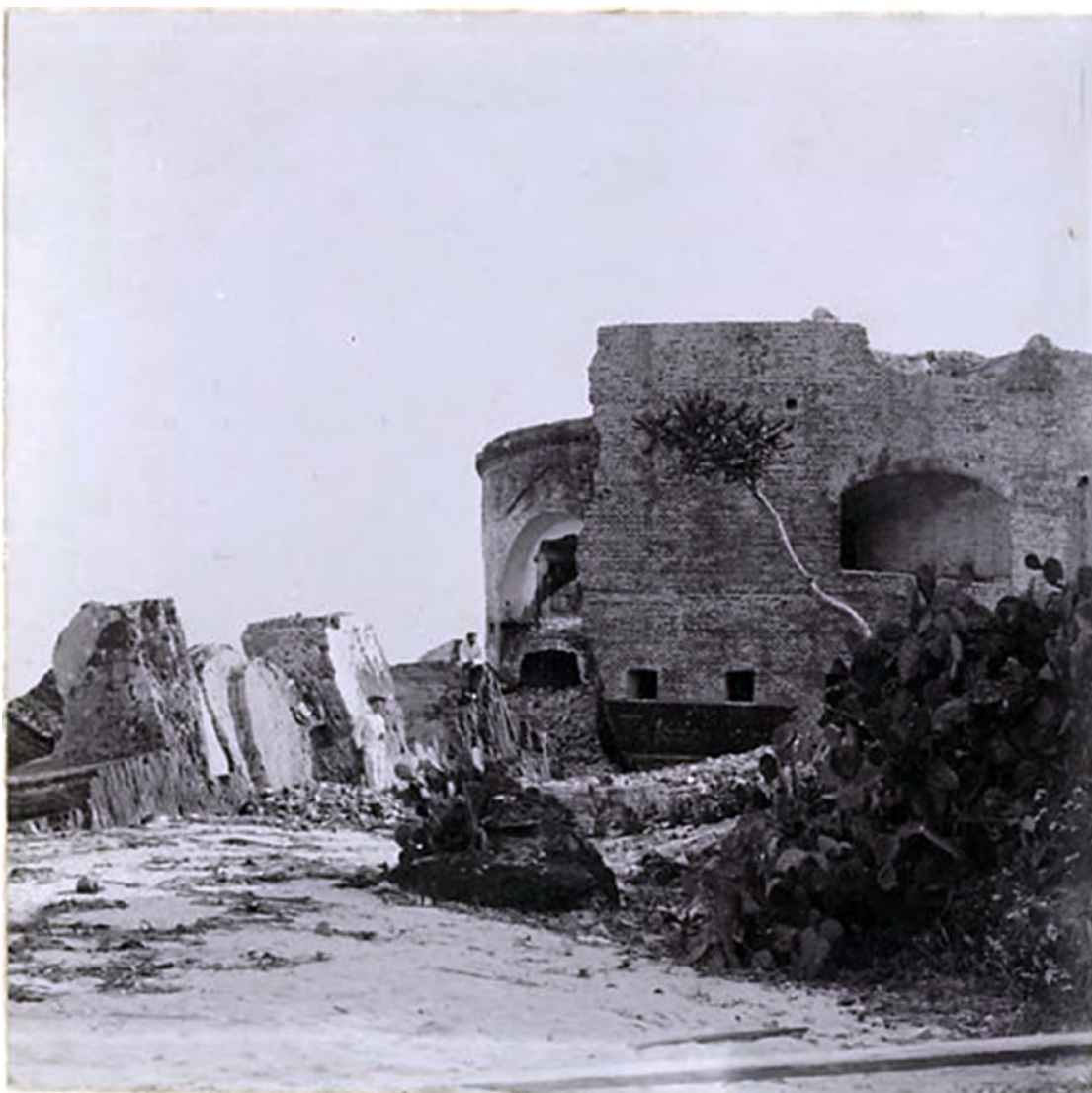
Benteng Bundar Pulau Kelor ketika dibongkar pada 1905. Dibongkar karena materialnya hendak digunakan untuk pembangunan Stasiun Cuaca di Pulau Onrust sumber : https://digitalcollections.universiteitleiden.nl/
