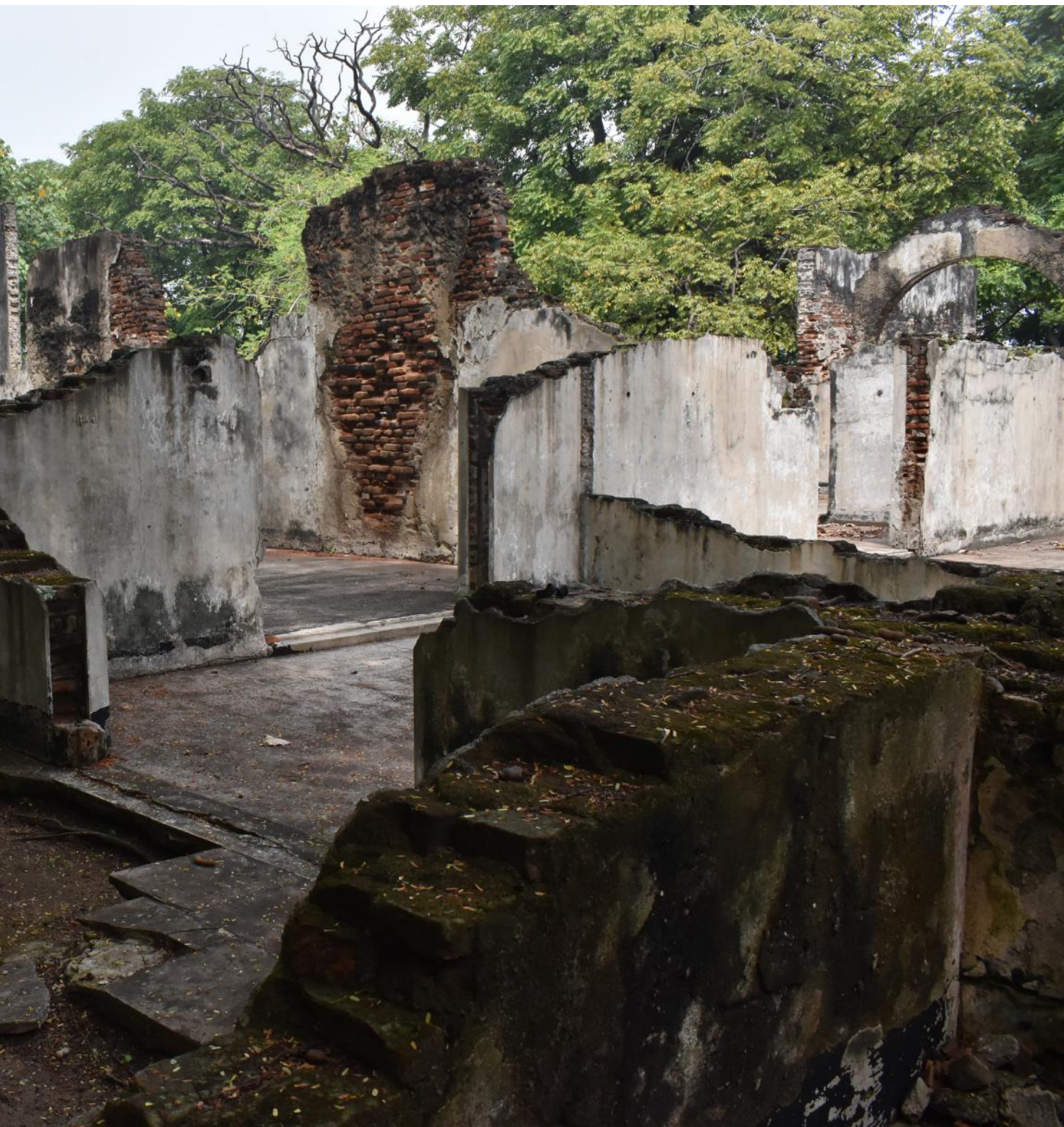
Foto sisa bangunan eksisting di Pulau Onrust sumber : koleksi Museum Kebaharian
