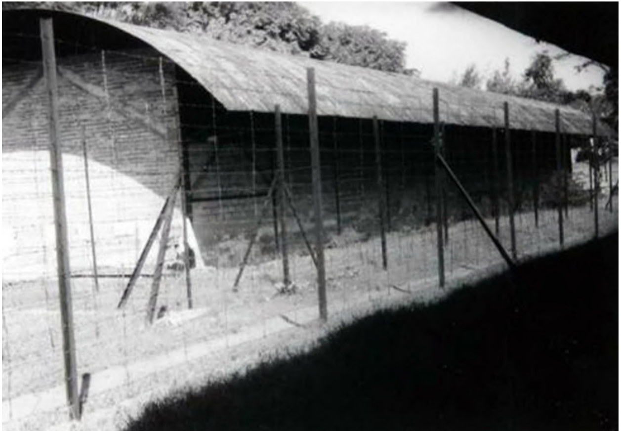
Tampak luar barak karantina Pulau Onrust, setiap barak dipisahkan dengan pagar, setiap empat atau enam barak dikelilingi pagar anti tikus sumber : Tropenmuseum
